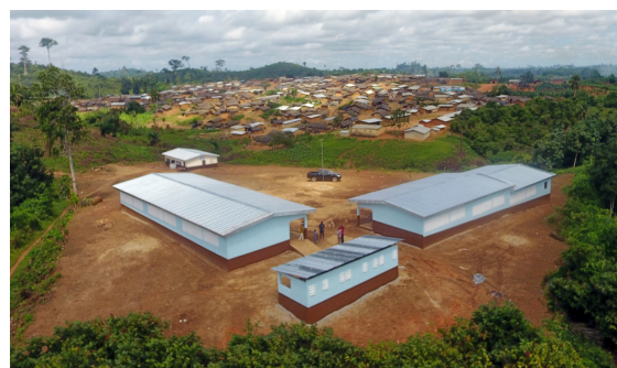
コートジボワールにて 2019 年にチョコレート・ボーナス還元により建設した学校
